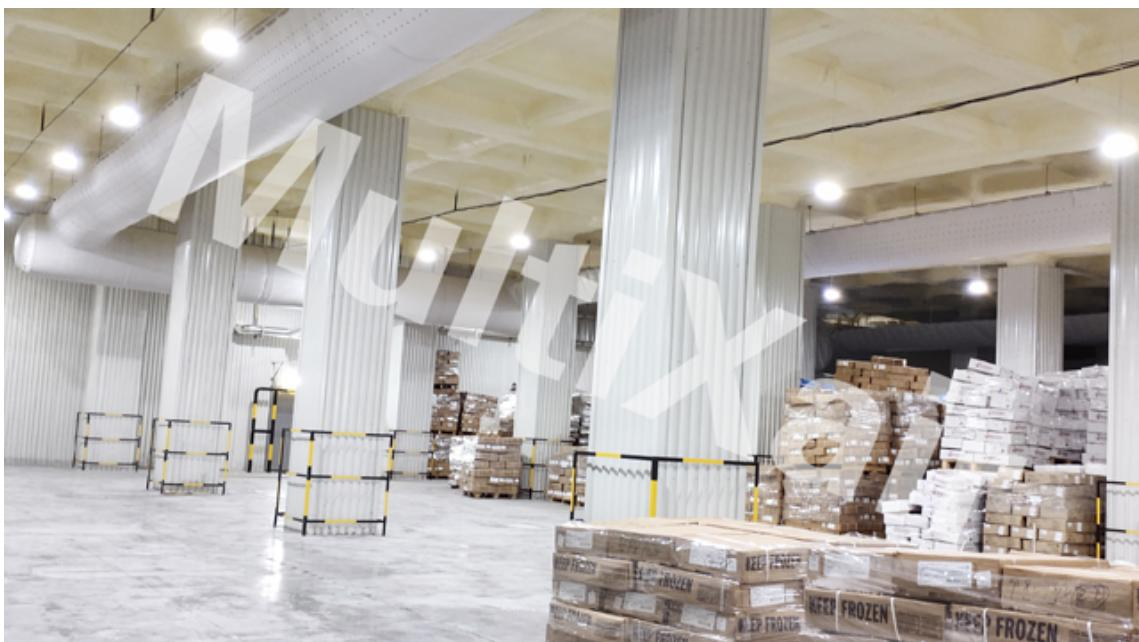
冷库中一种新型的送风方式是采用MX布风管，它是一种由特殊纤维织成的柔性空气分布系统，是集风口、送风管道、静压箱、保温材料、风阀等功能为一体的端送风系统。与传统金属风道系统相比，MX布风管送风具有送风均匀、无吹风感、干耗小、不结露、易清洁维护、重量轻等优点，还可以实现使用较小功率的电机实现较远送风距离，节能性好，贴顶式安装还能增加冷库的容积利用率。MX布风管在冷库中应用，一种是高低温冷藏库，要求库内温度均匀，货物干耗小，一种是低温操作加工间，要求无吹风感，有良好的舒适性。武汉布风管安装布风管，就选米希（上海）环境技术有限公司，用户的信赖之选，欢迎新老客户来电！
