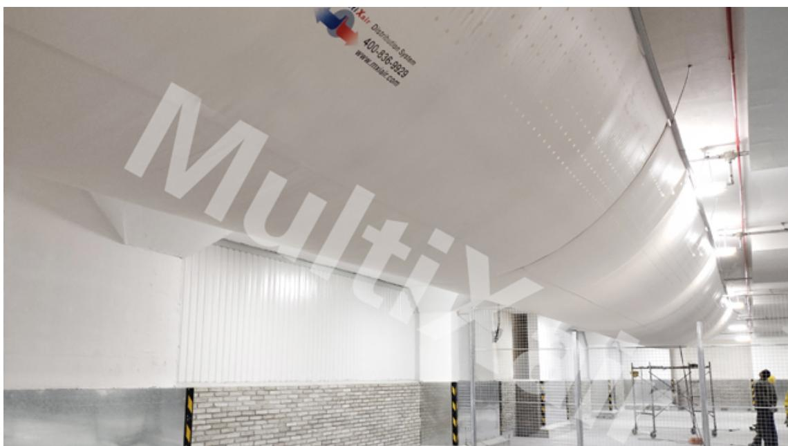
布风管用在温室棚增加挂果率温室棚种植技术给人们带来了丰富的瓜果蔬菜，温湿度控制对棚种植尤为重要，温湿度的过高或过低均会影响生产甚至导致病虫害，直接影响到产量、收入。布风管是一种由特种功能纤维织造而成的空调末端通风系统，可替代传统铁皮风管、玻璃钢风管、酚醛风管等。布袋风管送风精确均匀，通过CFD软件计算，通过纤维的缝隙或小孔、条缝、喷口出风，既可以沿管道径向送风，也可以轴向呈扇面送风，送风方向及距离精确，满足棚的工艺要求。并且布袋风管重量极轻，每平方 $150-400\text{g/m}^2$ 对棚骨架的荷载可以忽略不计。米希（上海）环境技术有限公司为您提供布风管，有需要可以联系我司哦！武汉布风管安装
